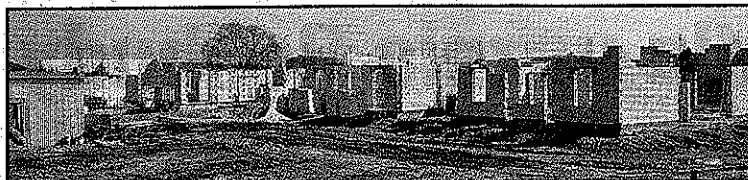
Stan budowy na 17 marca.
